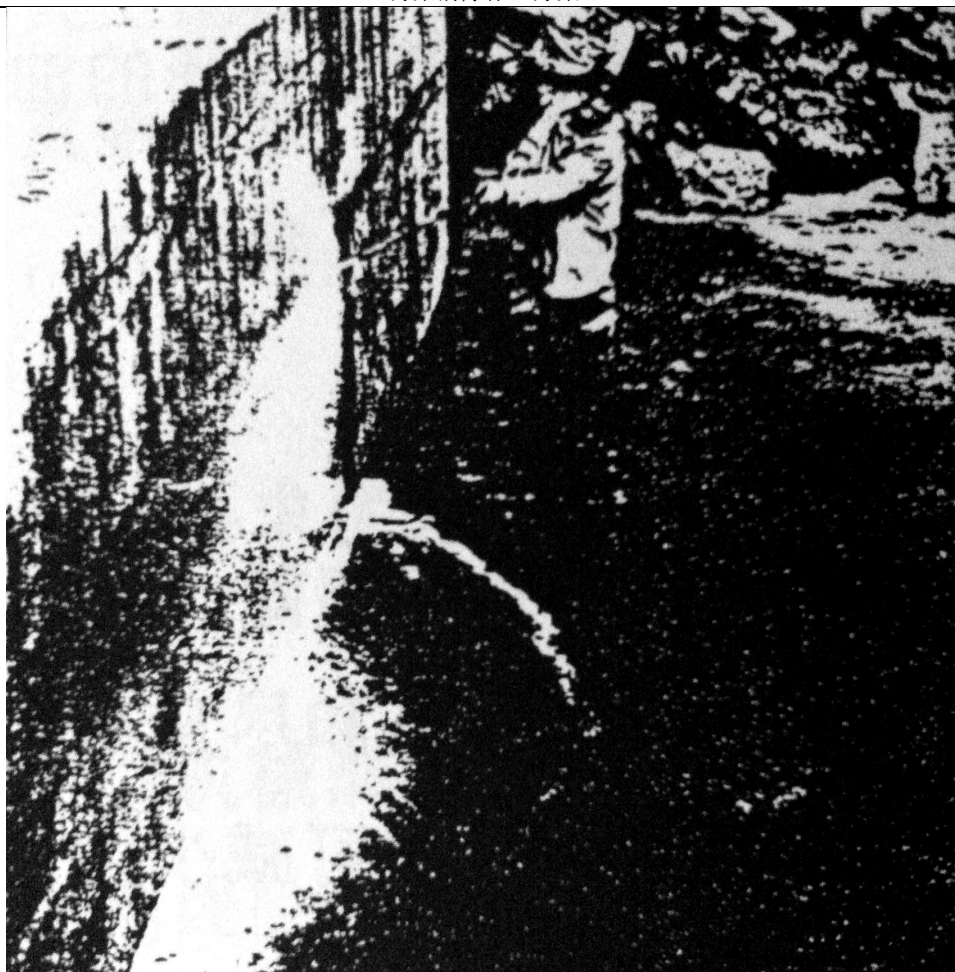
图 2-2 用含有分散剂的海水冲洗人工构筑物
